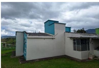
OBSERVACIONES: El puesto de salud exhibe una cubierta compuesta de asbesto cemento, cuya presencia conlleva riesgos significativos para la salud. Se observa que esta cubierta presenta notables deterioros, lo cual amplifica los peligros asociados con la exposición al asbesto.
