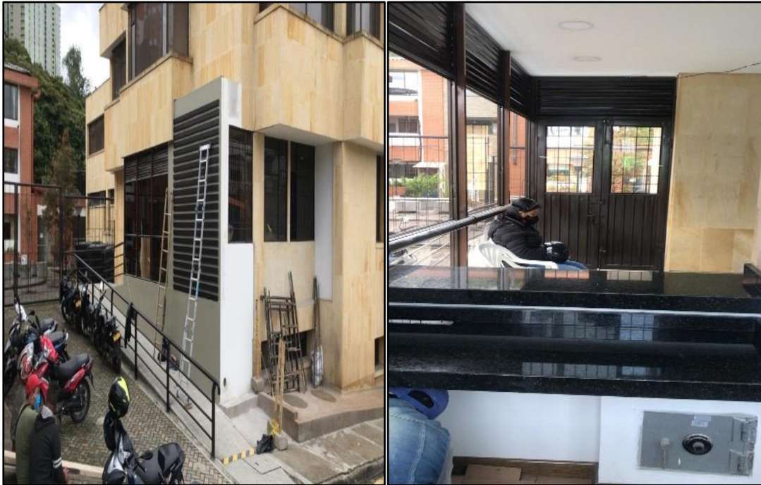
ADECUACIÓN AREA DE URGENCIAS HOSPITAL CIVIL
