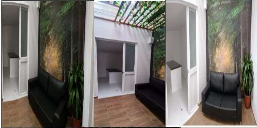
ADECUACIÓN SALAS DE PAZ H. CIVIL
