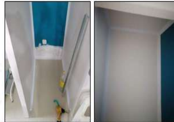
ADECUACION HUMEDADES Y PINTURA GENERAL
