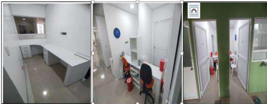
ADECUACIÓN LABORATORIO H. LA ROSA
