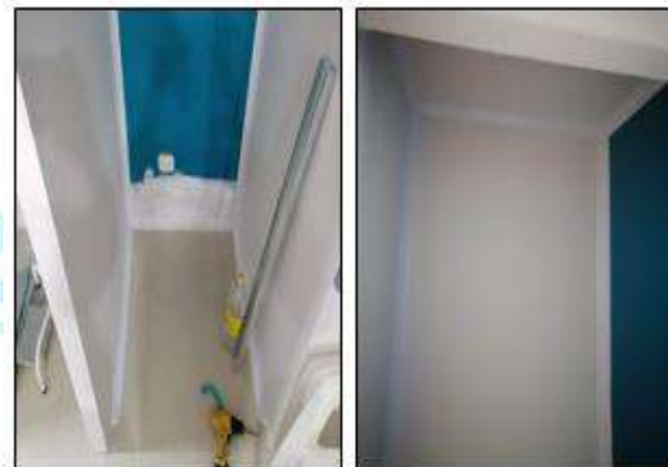
ADECUACION HUMEDADES Y PINTURA GENERAL
