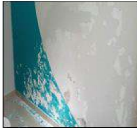
REPARACION DE HUMEDADES Y PINTURA EN MUROS
