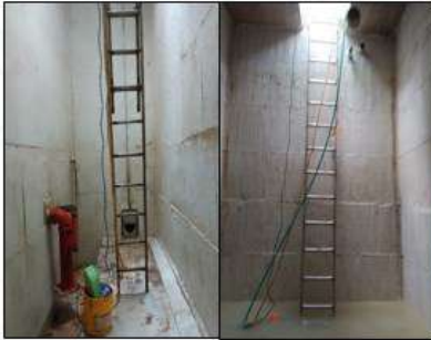
LIMPIEZA TANQUES DE ABASTECIMIENTO DE AGUA POTABLE H. SANTA MONICA
